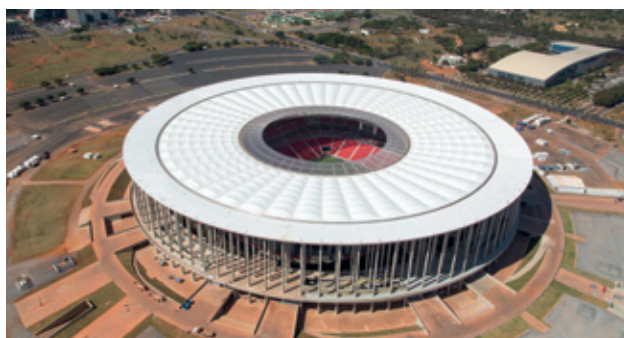
Estádio Nacional, Brasília: TROX ventilasjon- og klimaanlegg i alle nybygde verdenscupstadioner i Brasil
