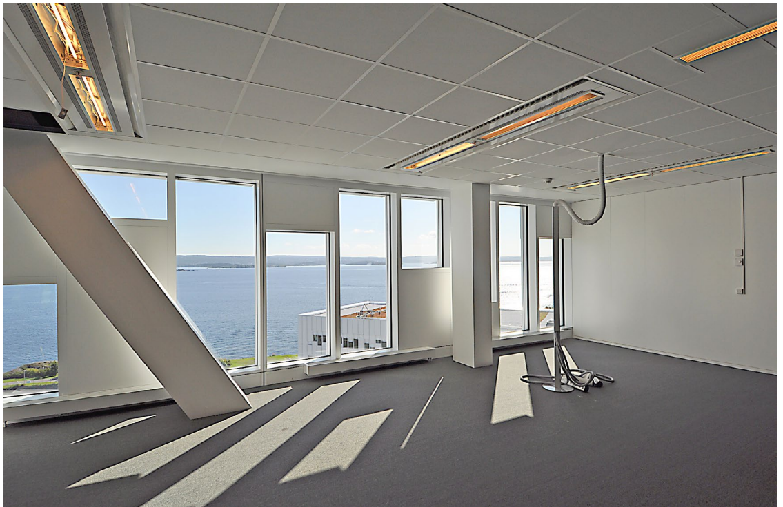
Equinor-bygget „Statoil-baffel“ Svalbard-I spesial med integrerte lys og sprinkler.
